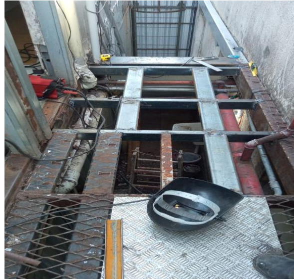
Restauração de Escada/Patamar Metálico
