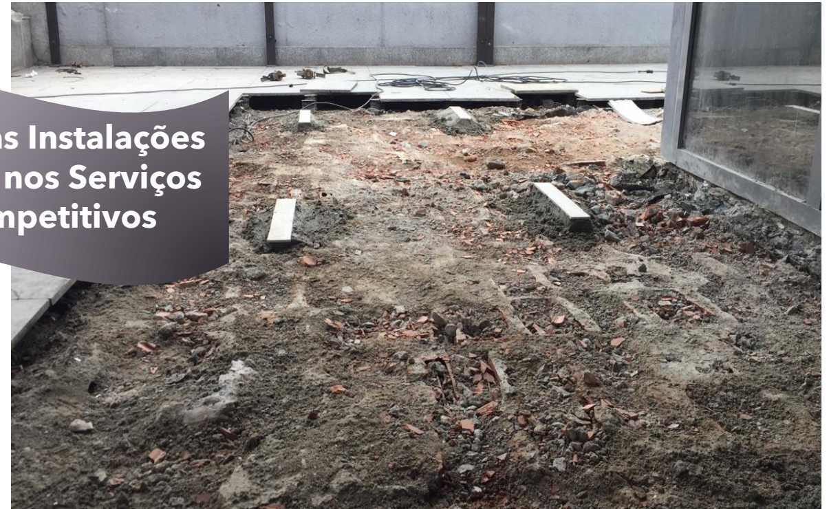
Execução de Contrapiso
